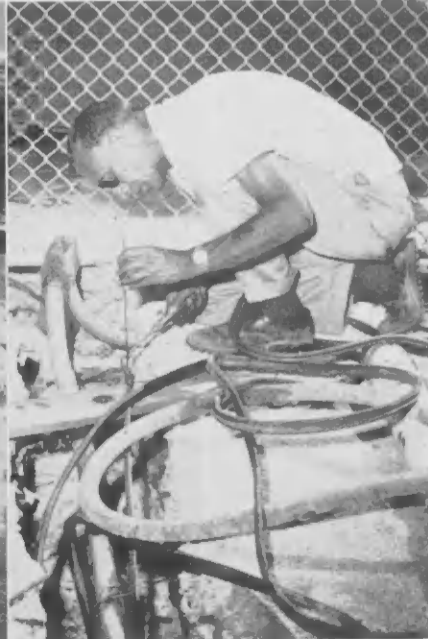
UN SISTEMA di grounding ta instalá door di trahadornan, ariba robéz. Otronan ta parehá e concreto bashá promer cu e sanja ta yená, ta soldear e cablenan cu ta bai pa e sistema di grounding di e substacion di gobierno, y ta traha encaje door di cual Lago su cable di corriente lo worde conectá na e equipo di switch di gobierno.
